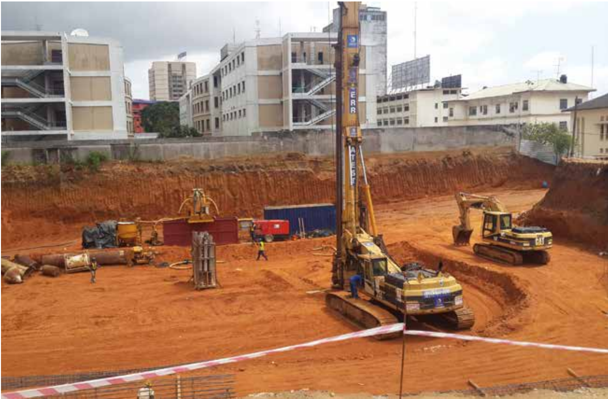
Embajada de Burkina Faso en Abidjan, Costa de Marfil Pilotes In situ
