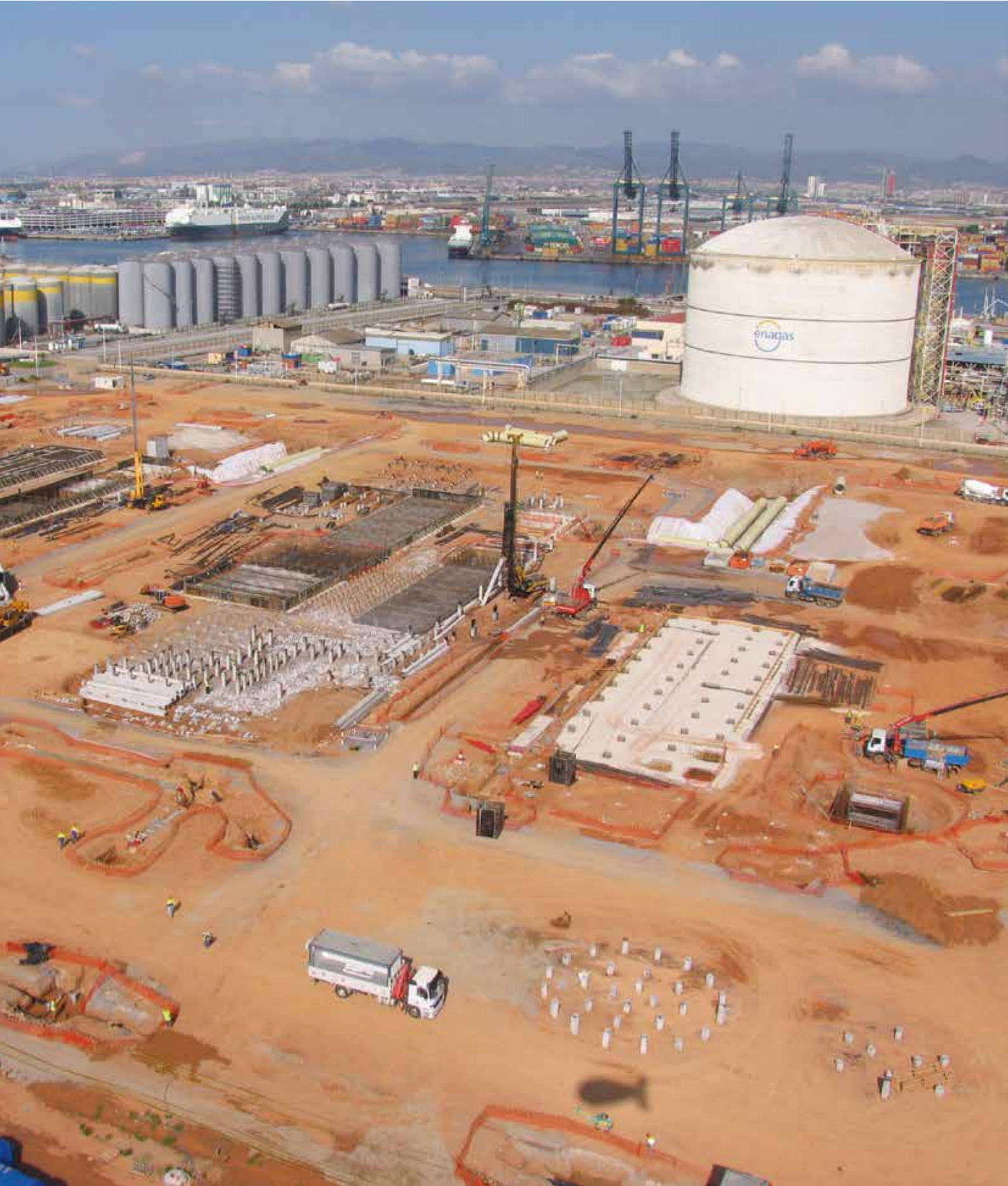
Central Ciclo Combinado Gas Natural. Barcelona Pilotes Prefabricados
