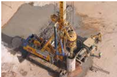
Pilotes de Barrena Continua
