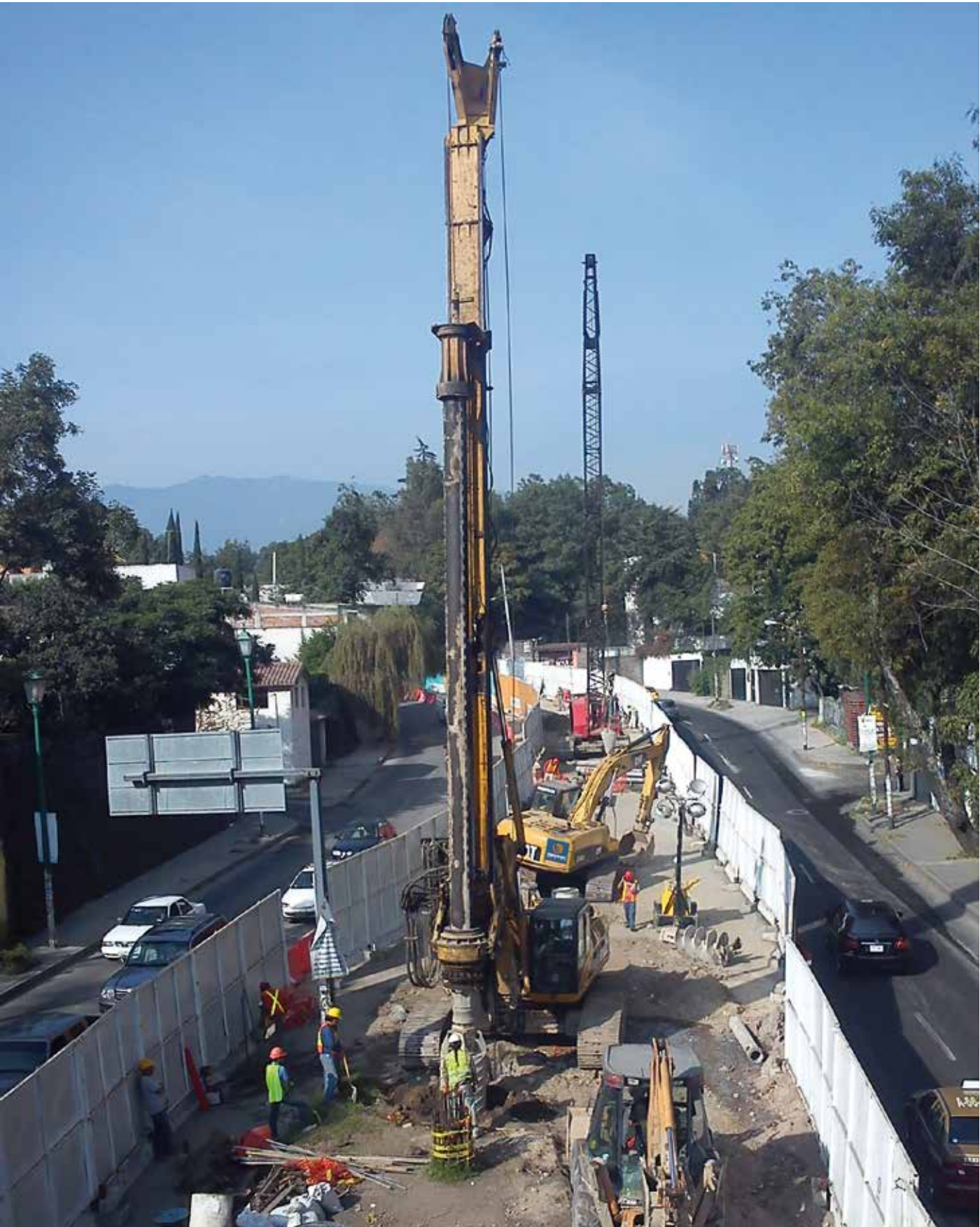
Ampliación vialidad Luis Cabrera, México DF. México Pilotes In situ
