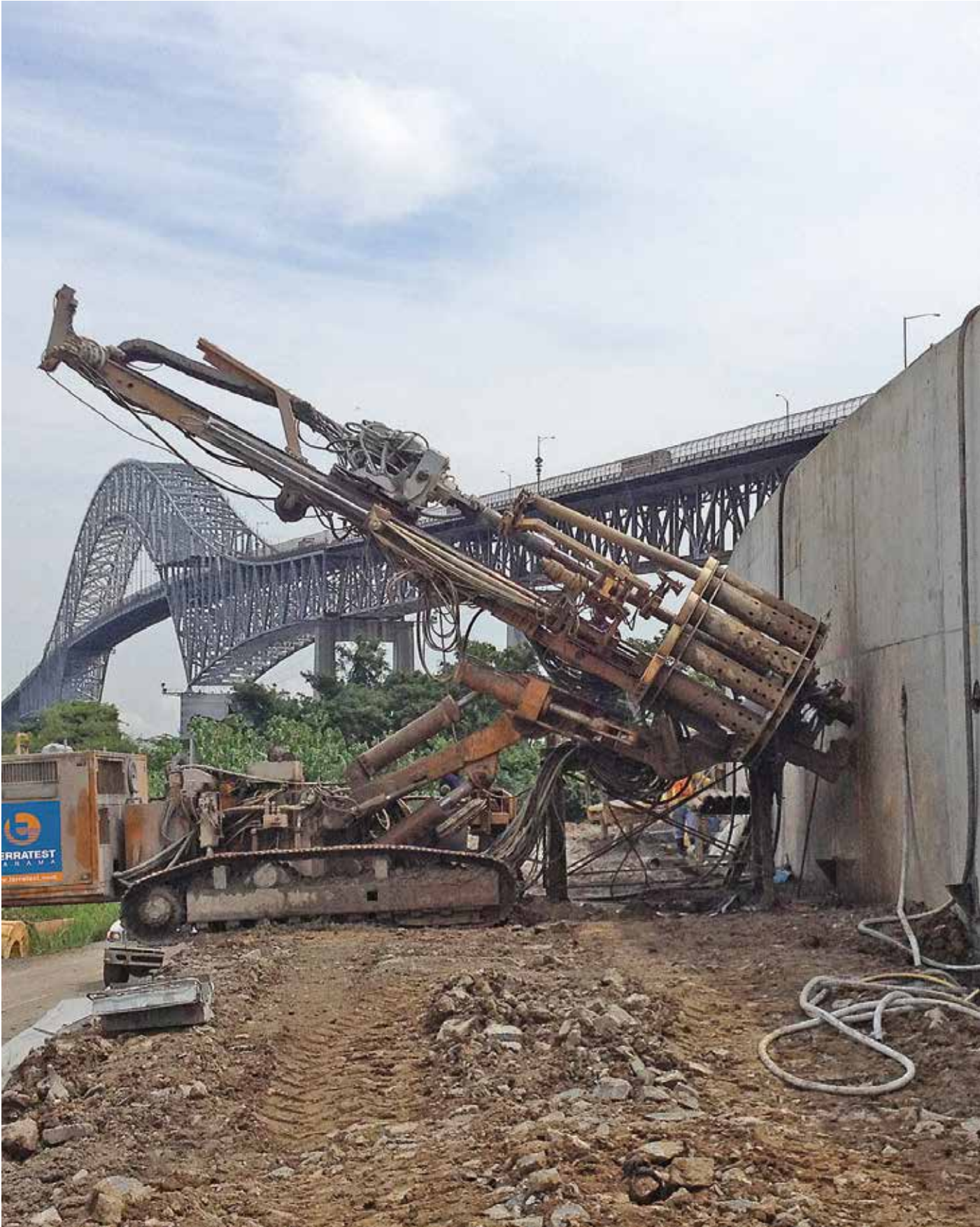
Rehabilitación Puente de las Américas, Ciudad de Panama. Panama Anclajes
