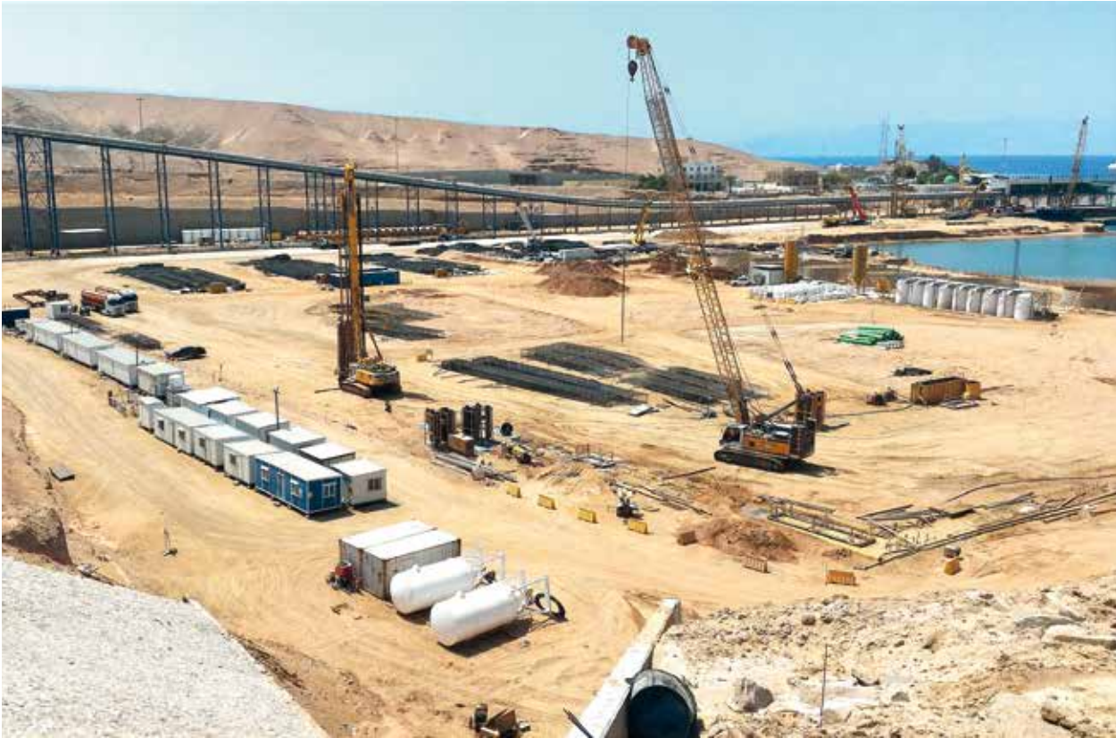
Nuevo Puerto de Aqaba, Fase II, Jordania Pantalla Fresada
