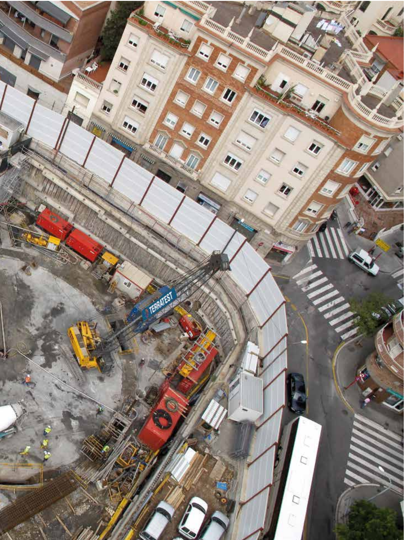
Línea 9 del Metro de Barcelona. Plaza Sanllehy, Barcelona Pantalla Fresada
