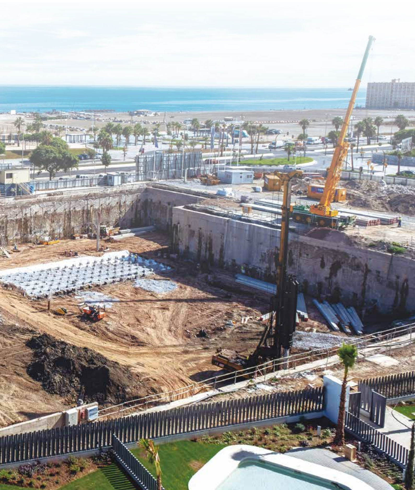
Picasso-Towers, Málaga. Pilotes prefabricados y Anclajes
