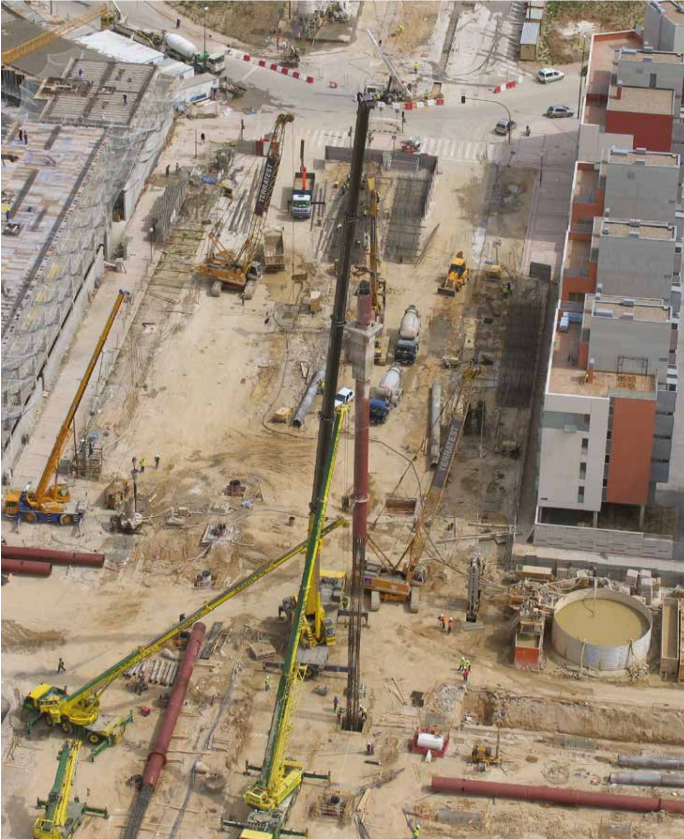
Metro Norte, Tramo 1A. Madrid Pilotes In situ y Muro Pantalla
