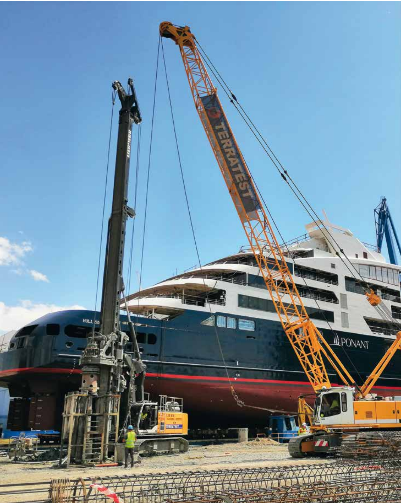
Ampliación del muelle, Puerto de Tulcea, Fase 7, Rumania Pilotes in situ
