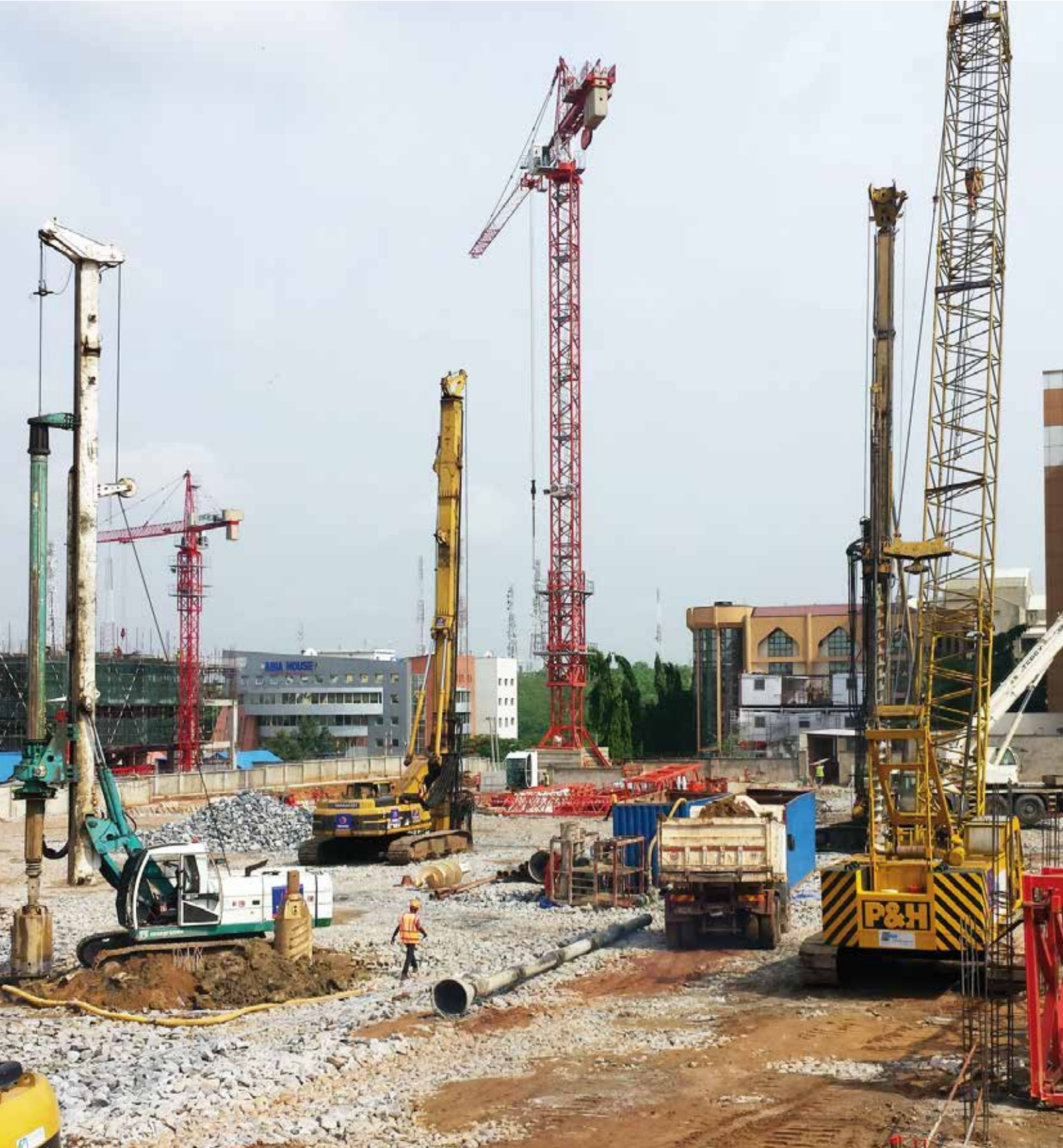
Sede FIRS. Abuja, Nigeria Pilotes In situ
