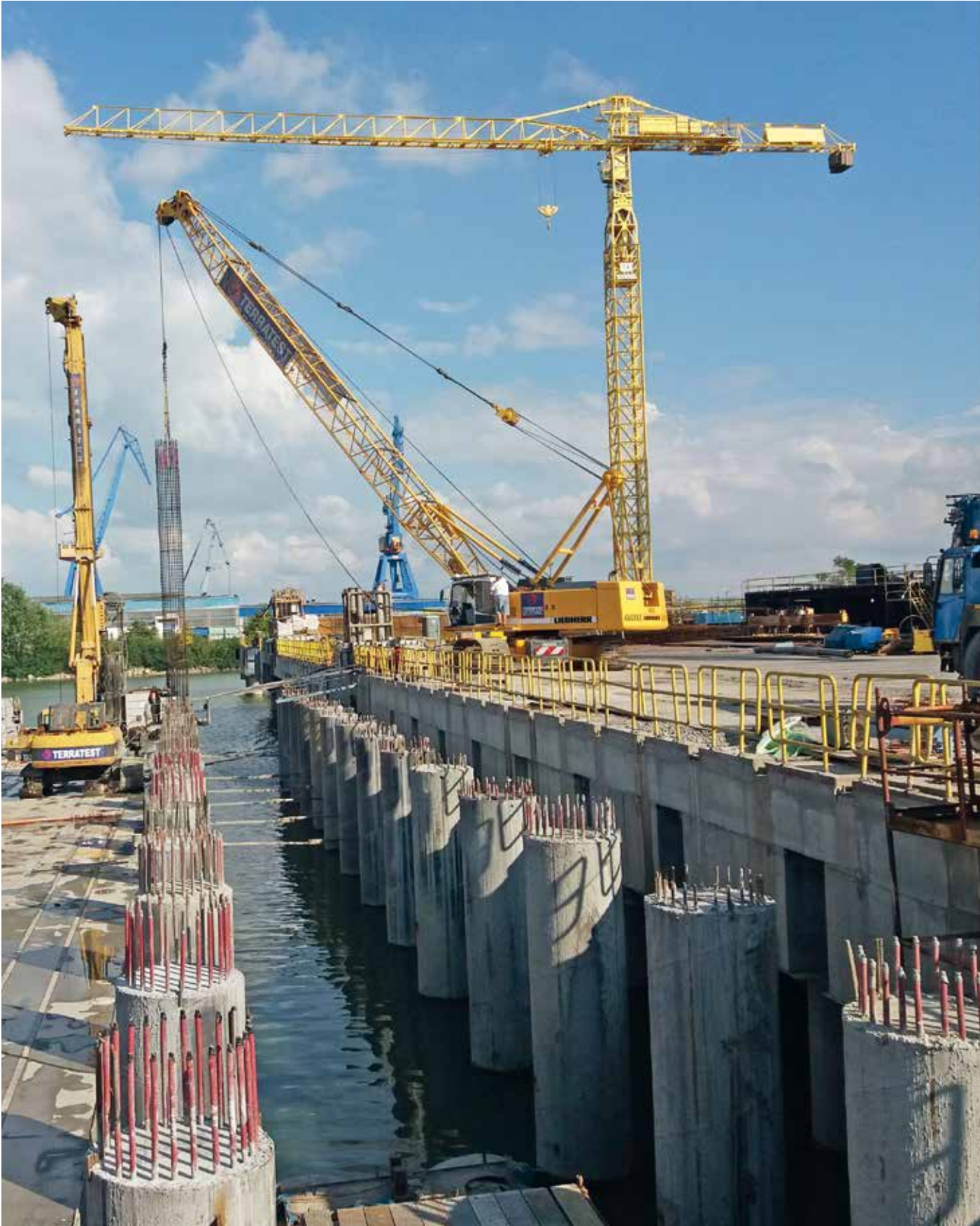
Ampliación del muelle, Puerto de Tulcea, Fase 4+5, Rumania Pilotes in situ
