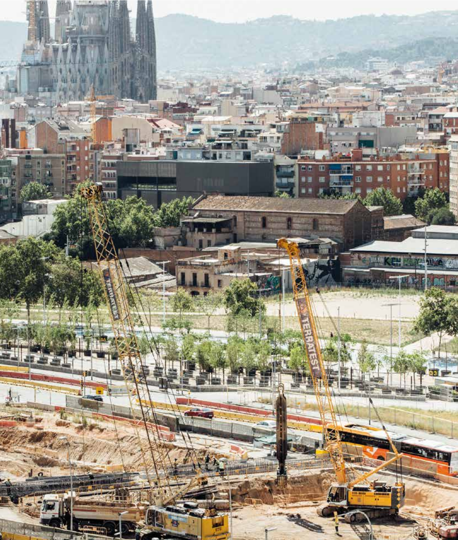
Plaza de les Glòries, Barcelona Muro Pantalla
