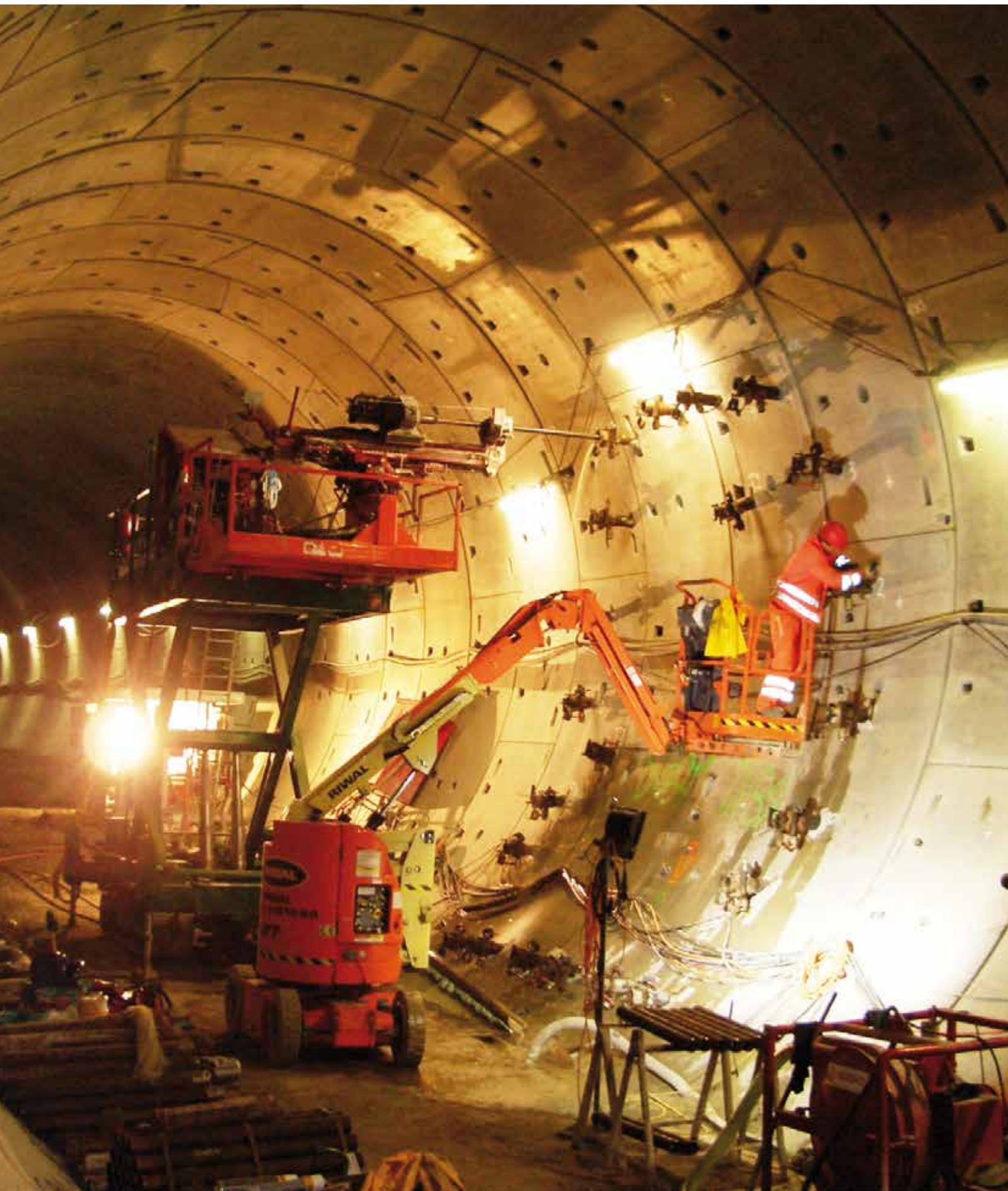
Túnel Hubertus. Autopista La Haya-Amsterdam, La Haya, Holanda Ground Freezing
