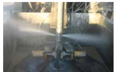
Inyecciones de Compensación y de Compactación
