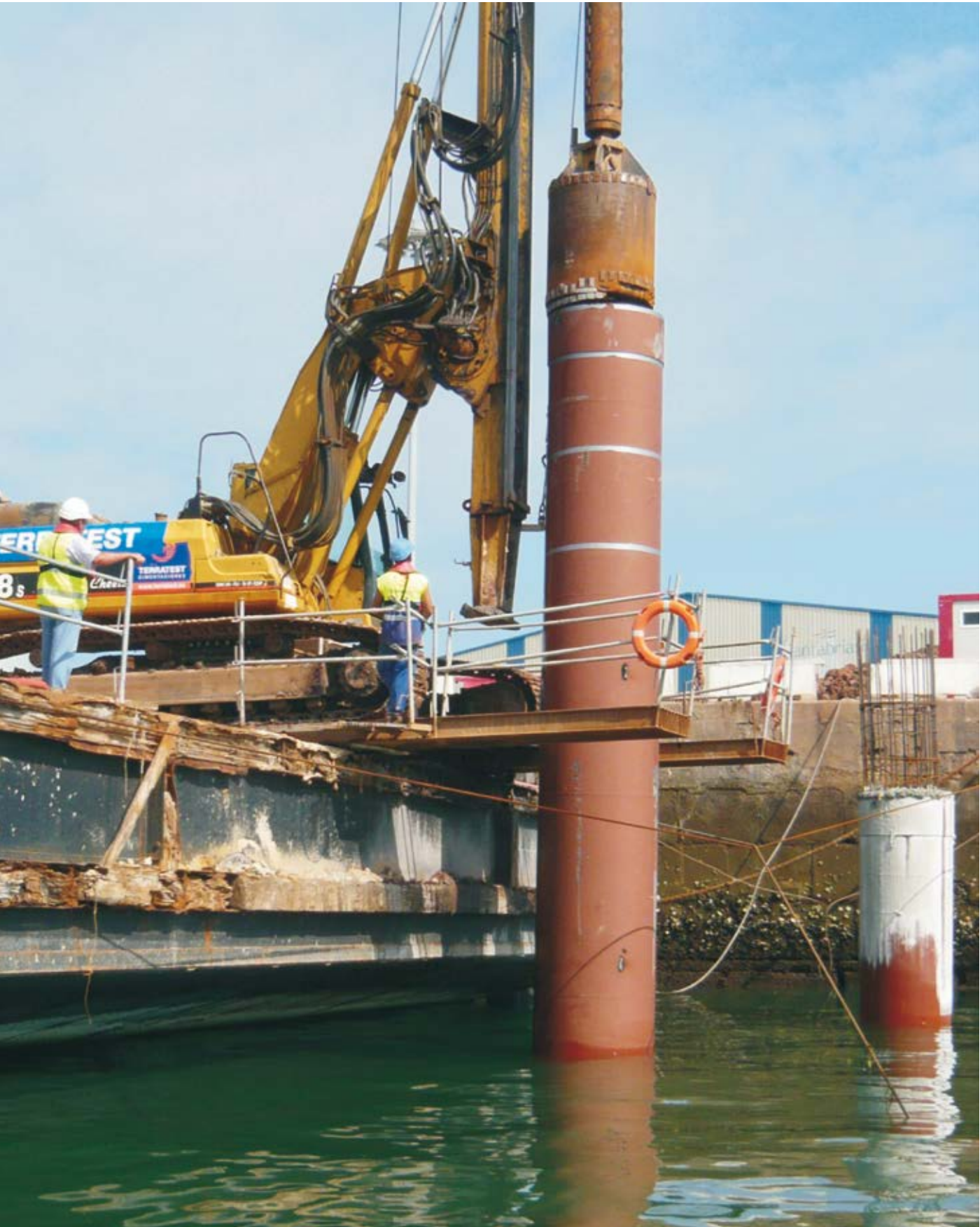
Fondation de pont à la jetée Maliaño. Port Santander, Espagne Pieux forés
