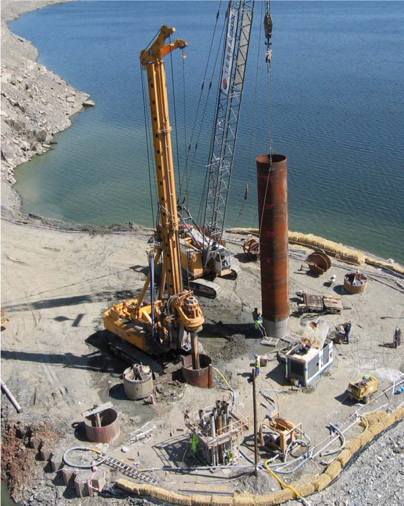
Pont de Manzanal (Barrage Ricobayo, Espagne) Pieux forés
