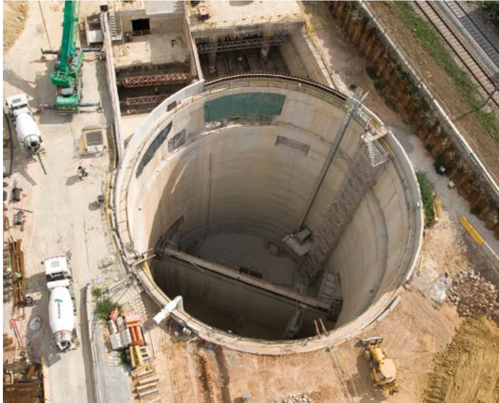
Barcelone métro ligne 9. Torrassa Gare de chemin de fer. Barcelone, Espagne Ateliers de forage avec Hydroraise
