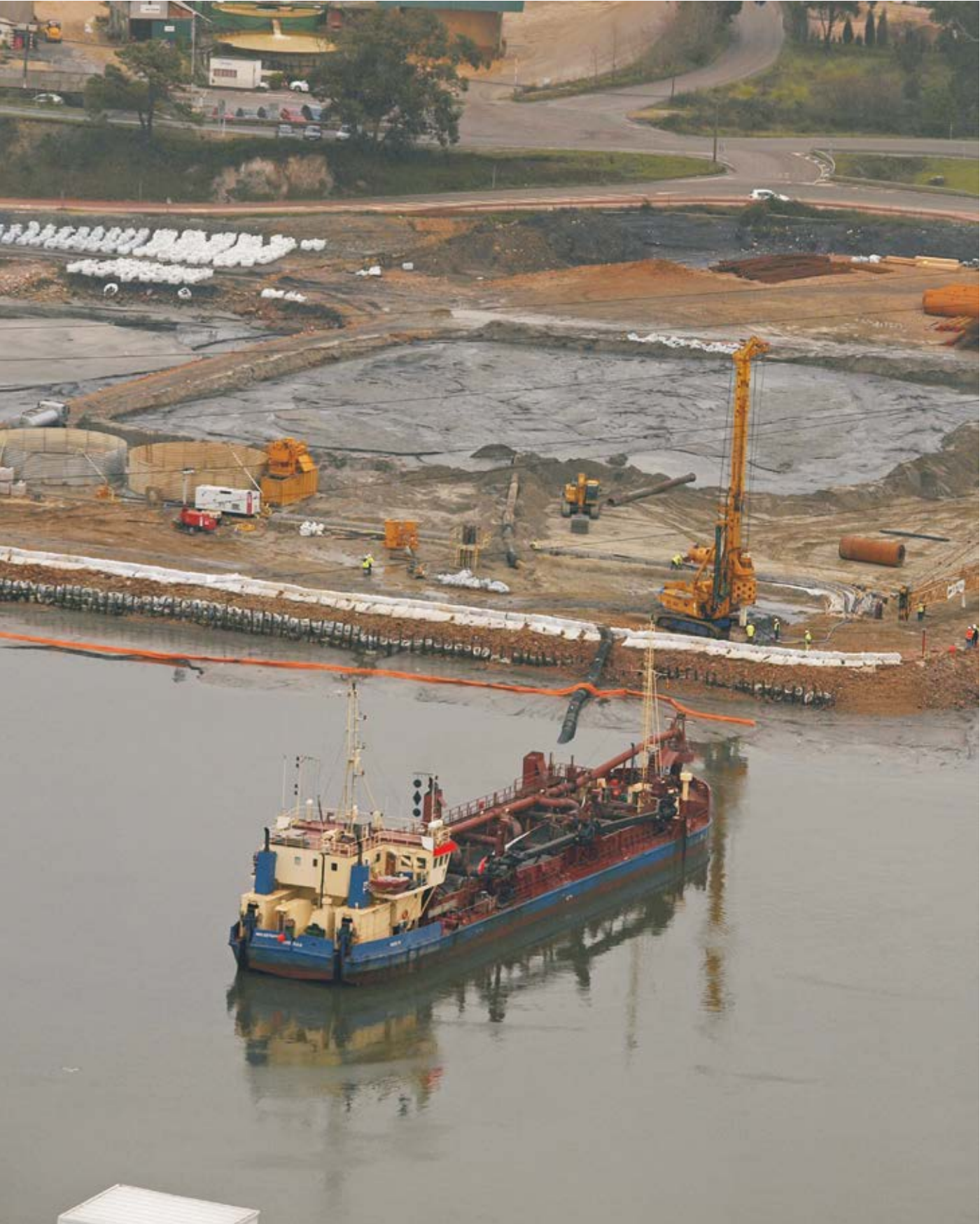
Phase 1 de développement. Port Ria d'Aviles Pieux forés
