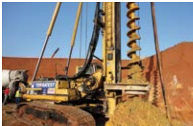
Pieux battu en béton
