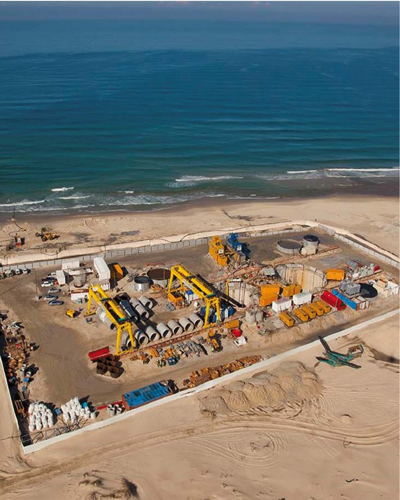
Tunnels sur la rive et off shore. Usine de dessalement, Sorek, Israël Tunneling
