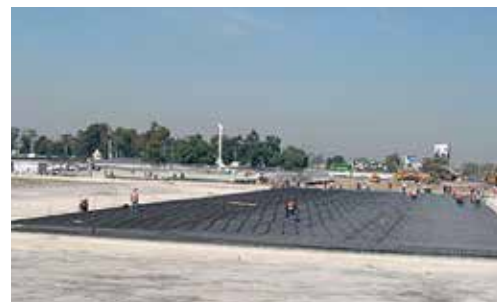
Centro de Distribución Herdez Zumpango, Mexico
