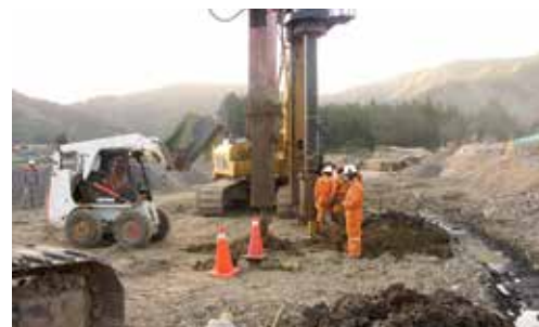
Patio de Almacenamiento-Holcim Nobsa, Colombia
