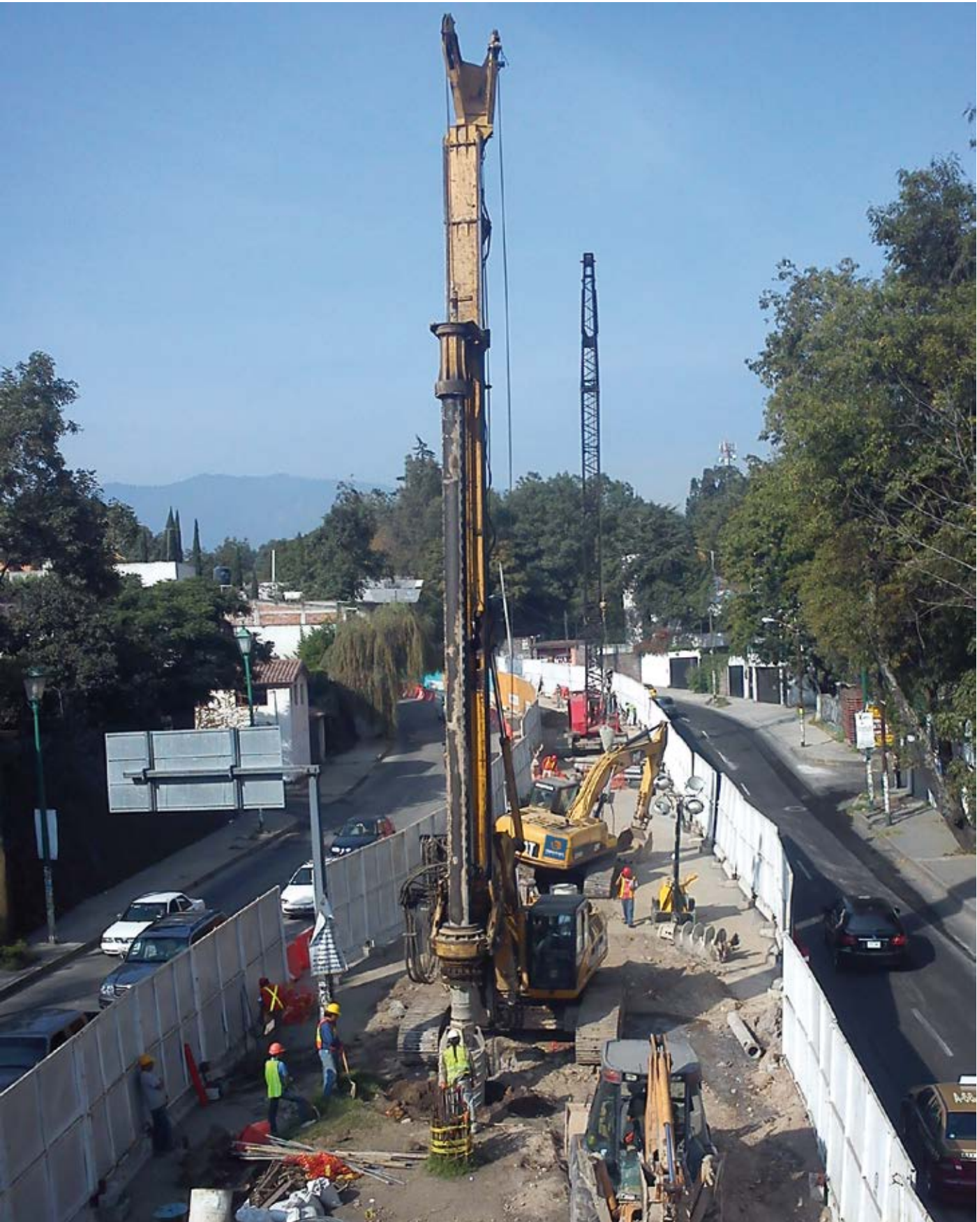
Extensão da autoestrada Luis Cabrera, Cidade do México, México Estacas moldadas
