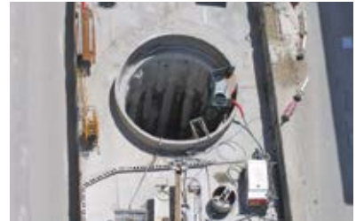
Grouting de compactação Injeção sólida
