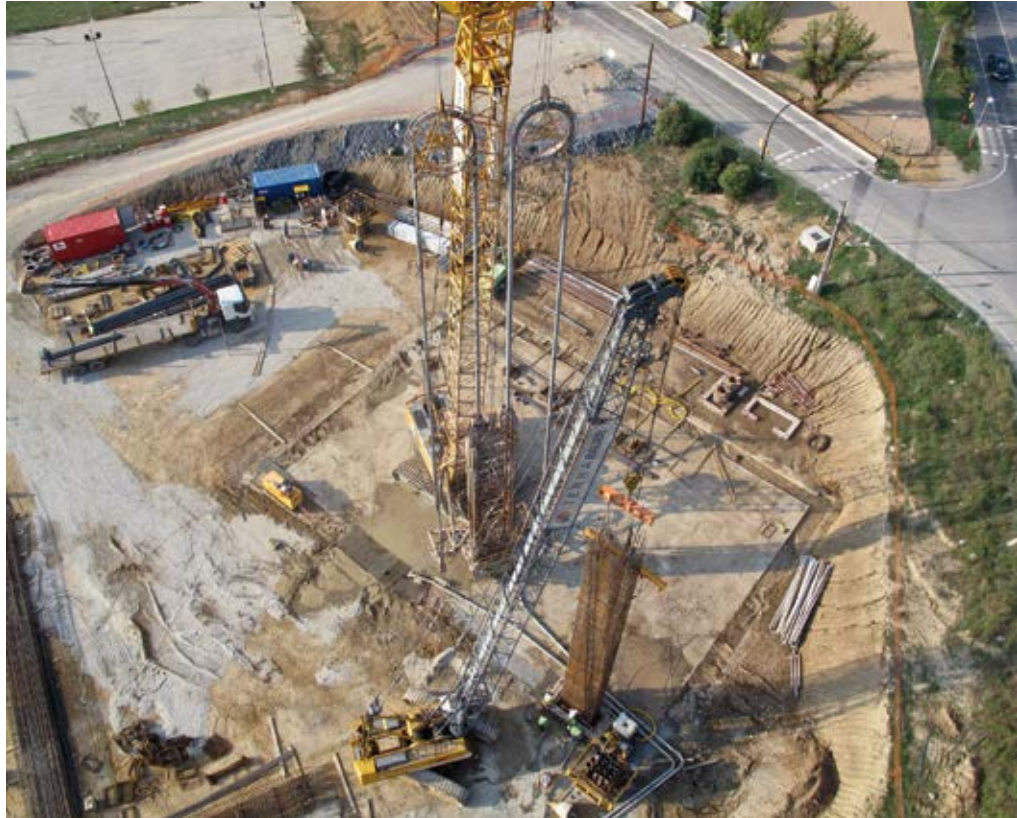
Escavação de Sant Ponz, Girona, Espanha Trincheirador
