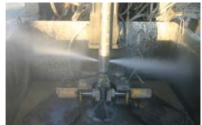
Grouting de compensação
