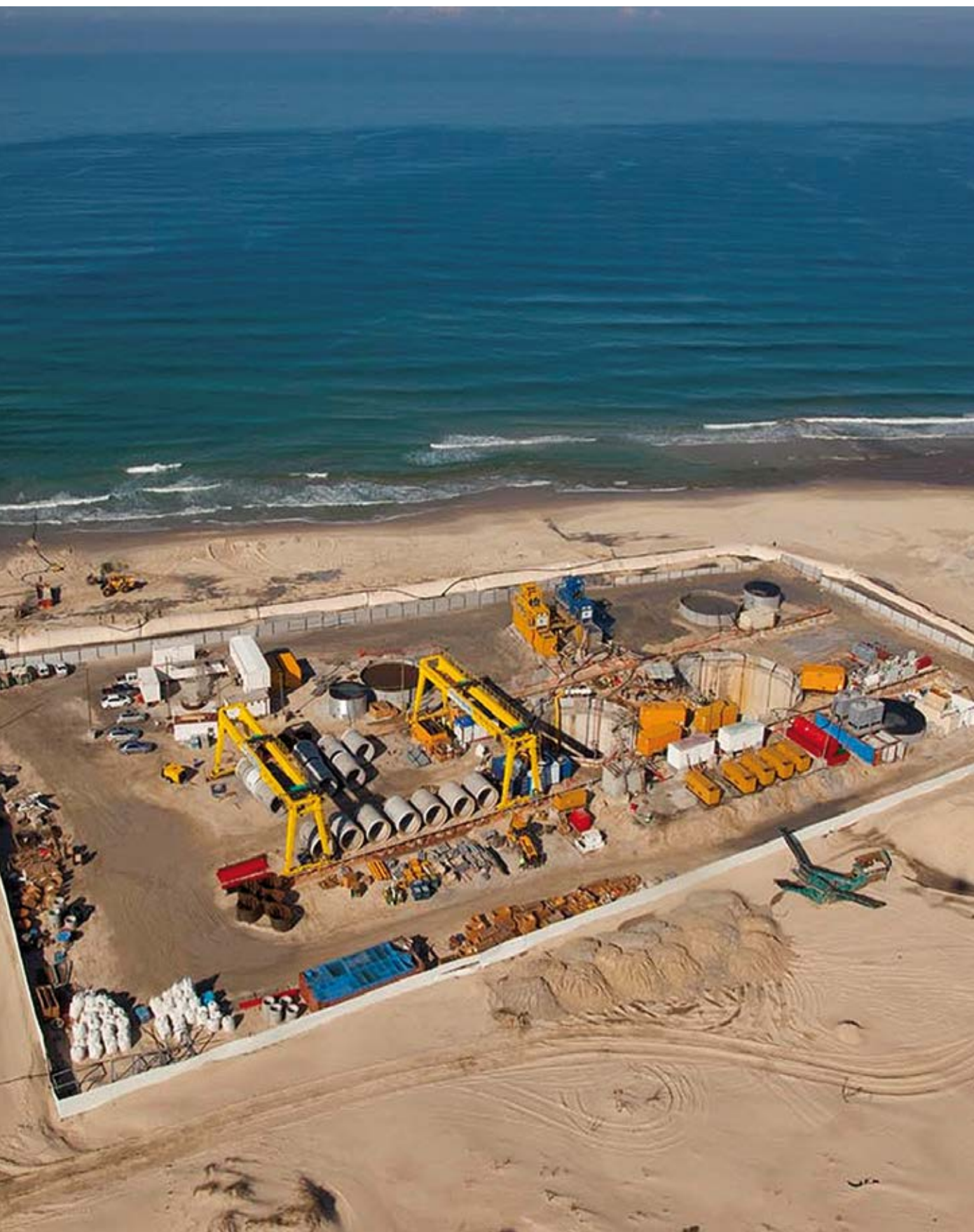
Túneis no mar e em terra. Central de dessalinização, Sorek, Israel Construção de túneis
