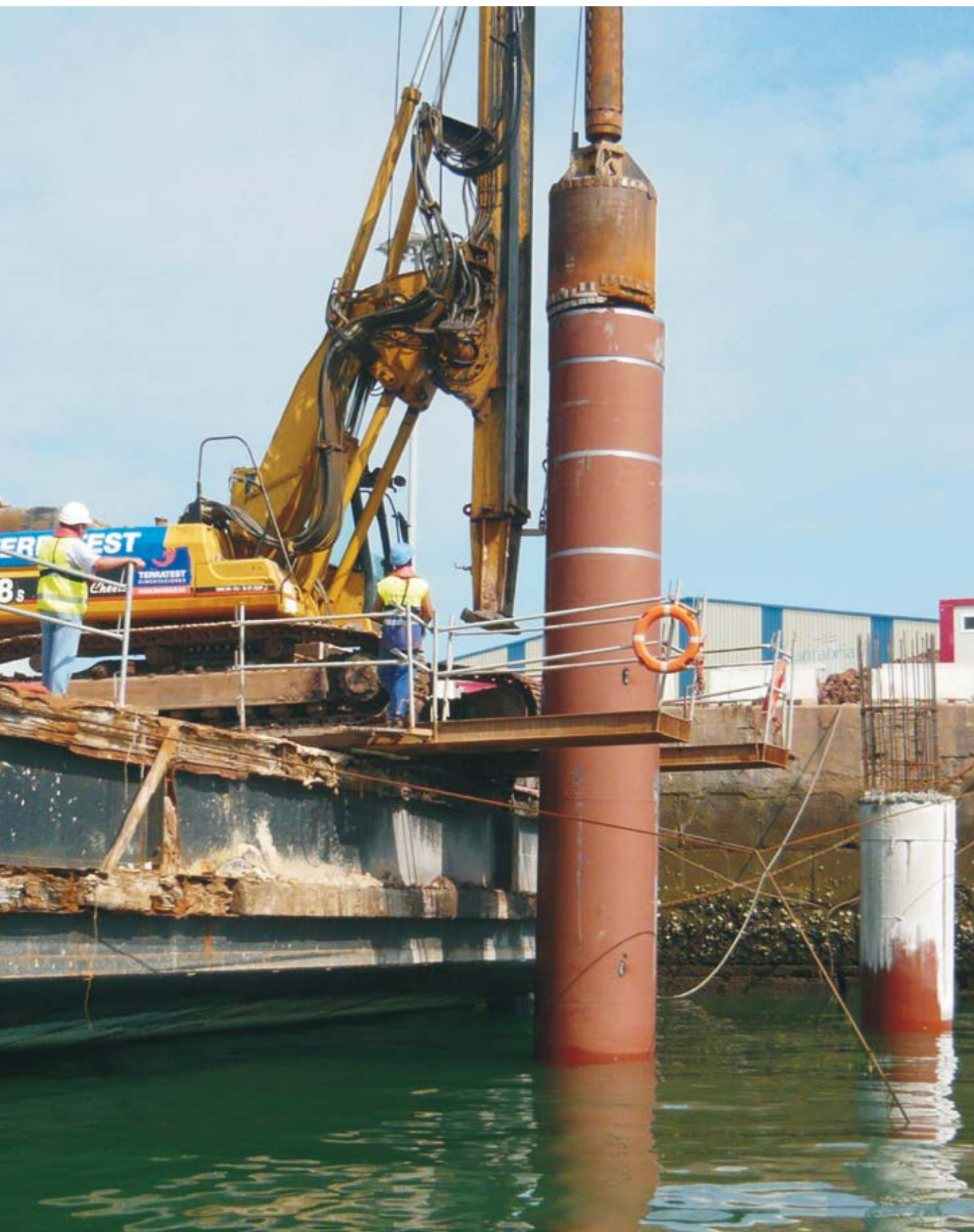
Fundação de ponte no molhe Maliaño, porto de Santander, Espanha Estacas moldadas
