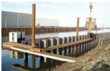
Estacas prancha / Contensões metálicas
