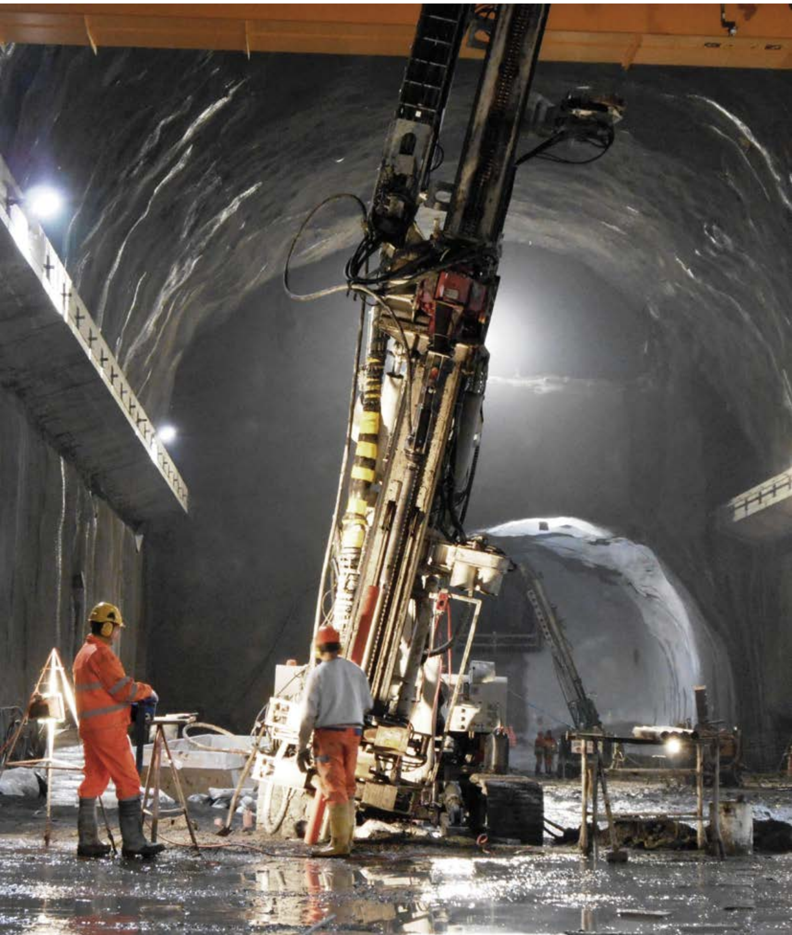
Segunda central hidroelétrica de Hongrin Léman Injeção de calda de cimento ou Cortina de injeção (no caso de ser em barragem)
