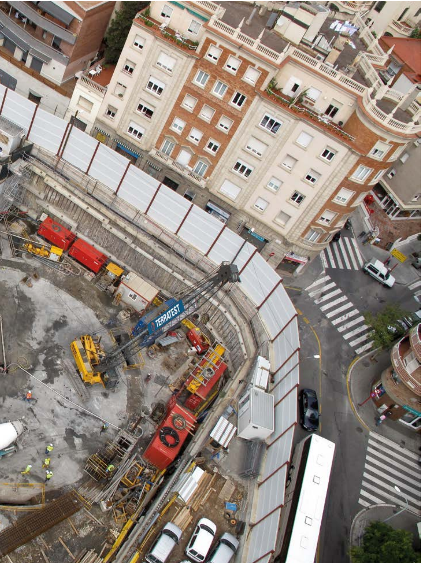
Metro de barcelona, linha 9. Plaza Sanllehy, Barcelona, Espanha Trincheirador
