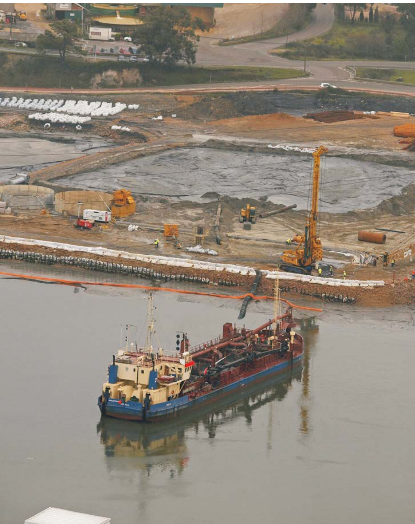
Desenvolvimento fase I. porto da Ria de Avilés Estacas moldadas
