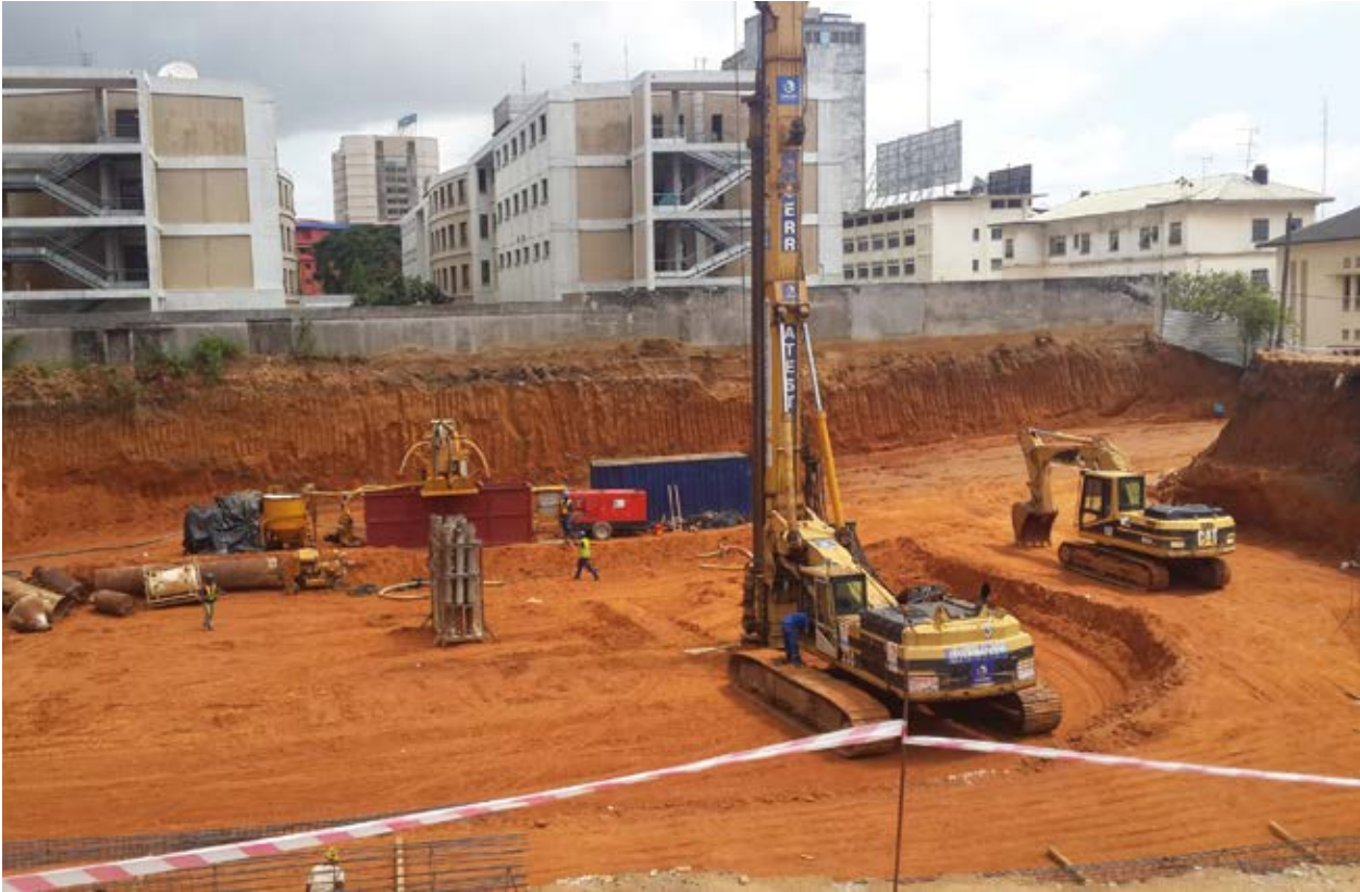
Embaixada do Burkina Faso em Abidjan, Costa do Marfim Estacas moldadas
