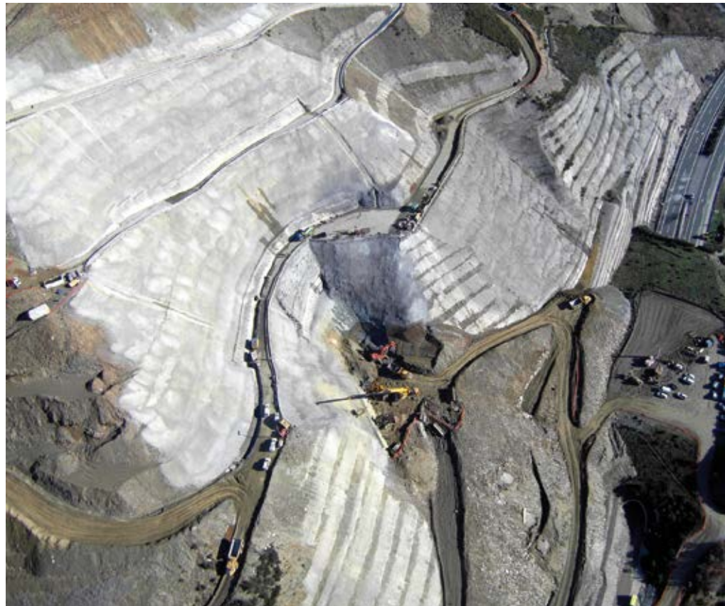
Trabalhos de contenção para deslizamento de terras na autoestrada A-6. León, Espanha Pregagens ou Acoragens
