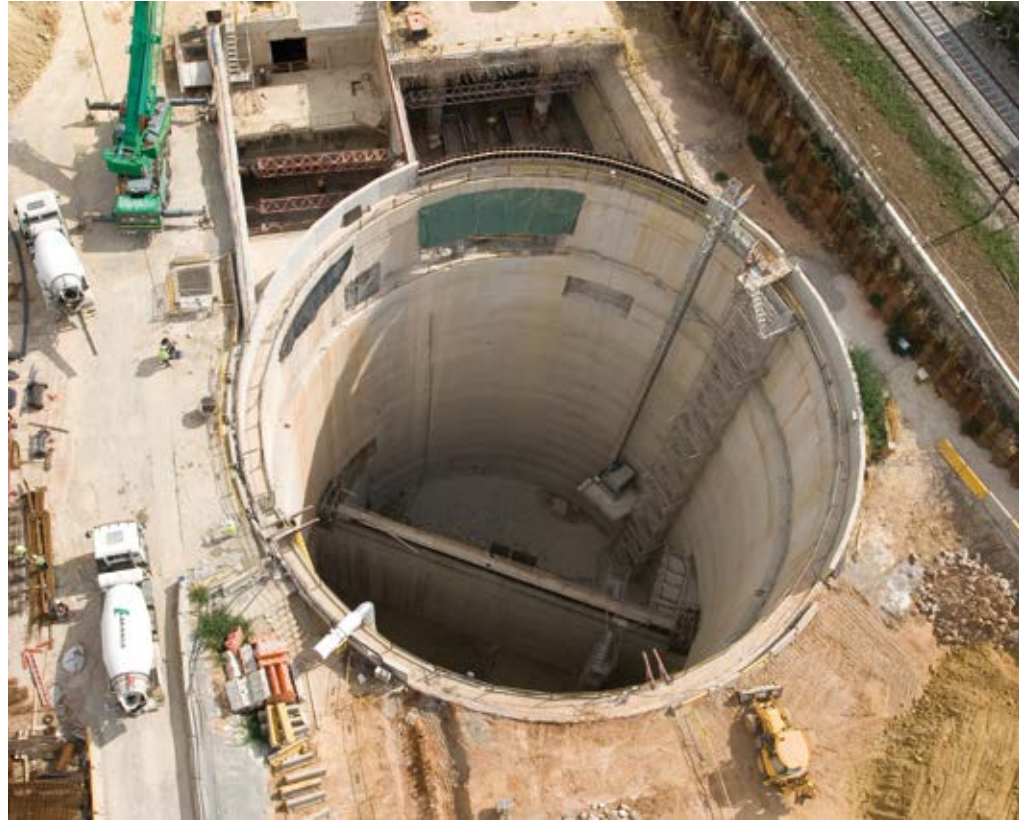
Metro de Barcelona, linha 9. Estação ferroviária de Torrassa. Barcelona, Espanha Treincheirador
