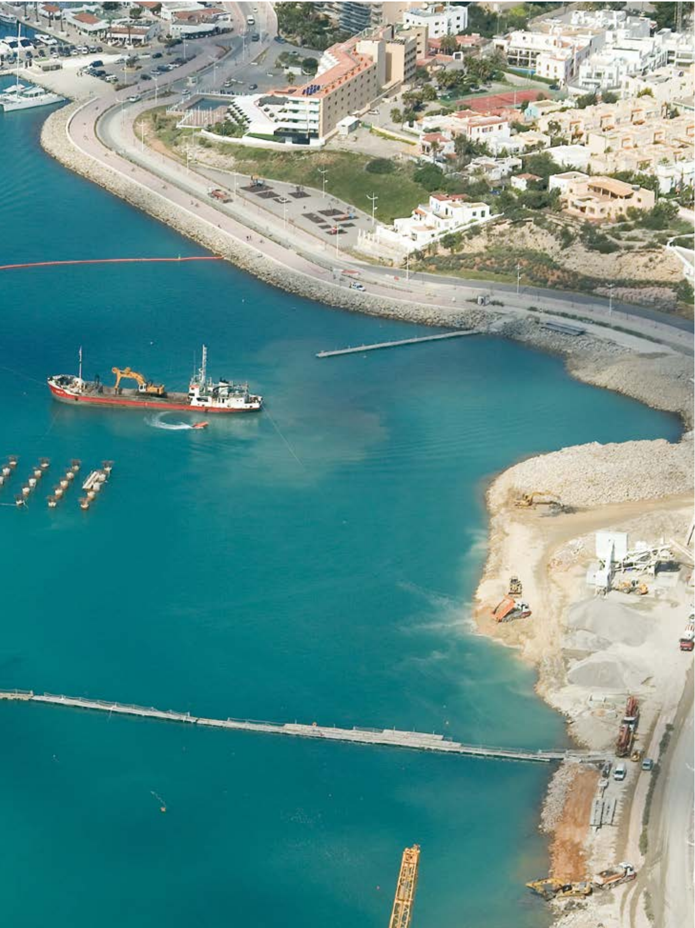
Doca Botafoch. Porto de Ibiza, Espanha Estacas moldadas
