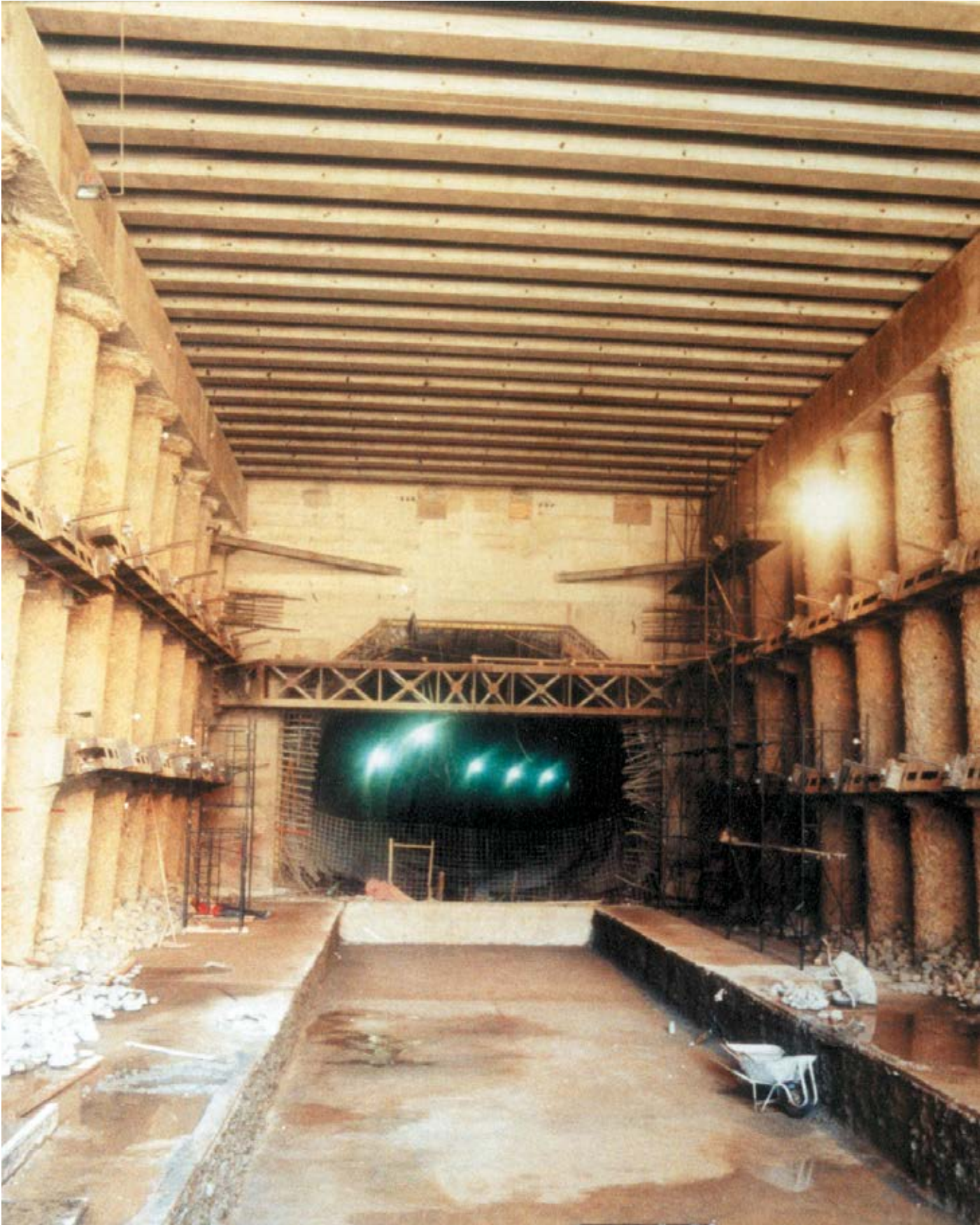
Estação de metro de Bellas Artes, Santiago do Chile, Chile Estacas moldadas
