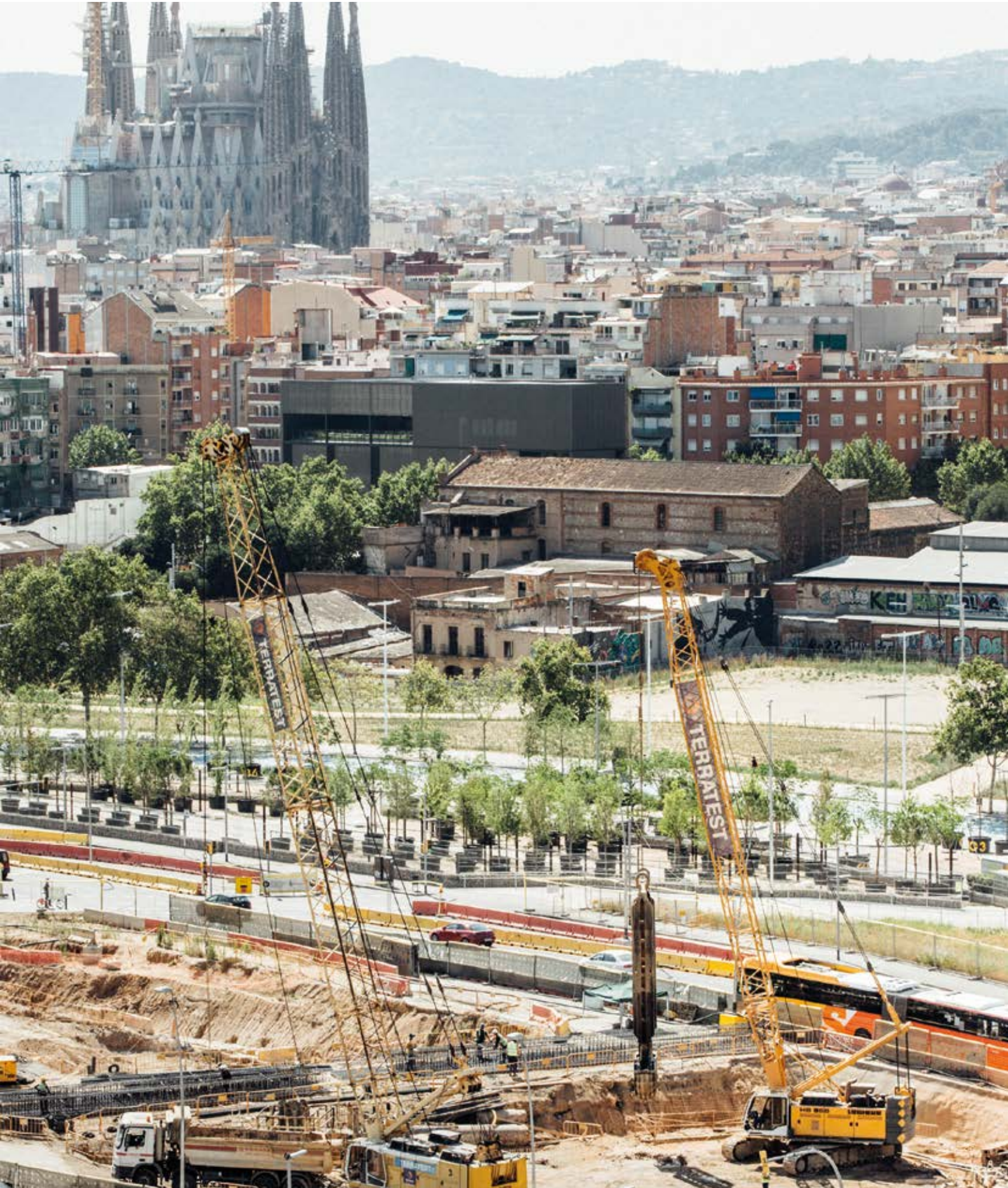
Plaza de les Glòries, Barcelona Paredes Moldadas
