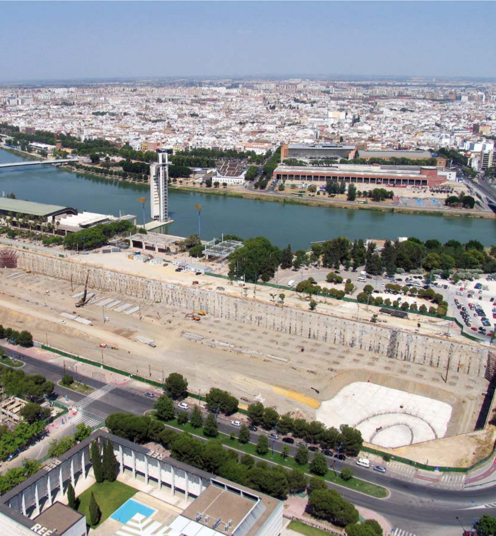
Paredes de fundação e de tipo moldada no projeto Torre Cajasol. Sevilla Paredes de tipo moldada
