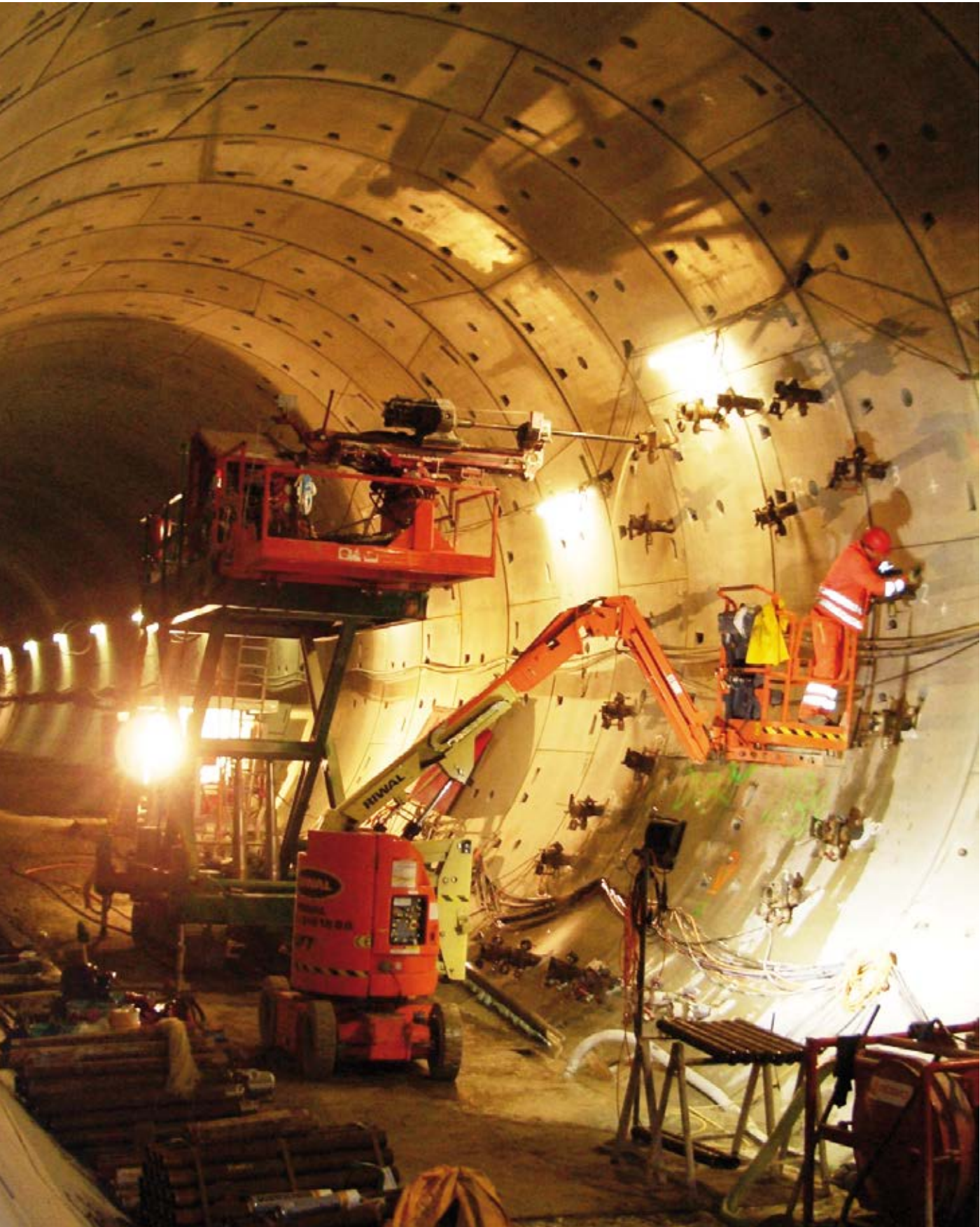
Túnel Hubertus. Autoestrada Haia-Amesterdão, Haia, Holanda Congelamento de Solos
