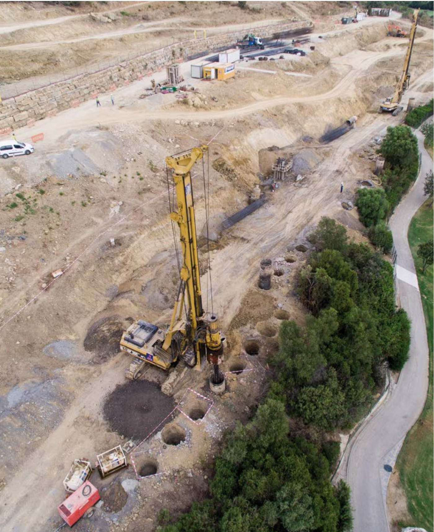
Estabilização de taludes para construção de 15 moradias em Finca Cortesin, Casares, Málaga Estacas moldadas
